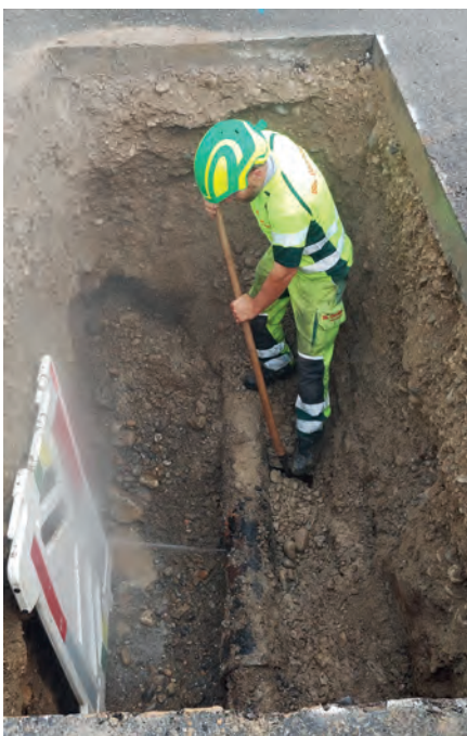
Freilegung und Reparatur von Rostloch an der Hauptleitung mit 200 mm Durchmesser in der Hauptstrasse beim Kafihus 12.
