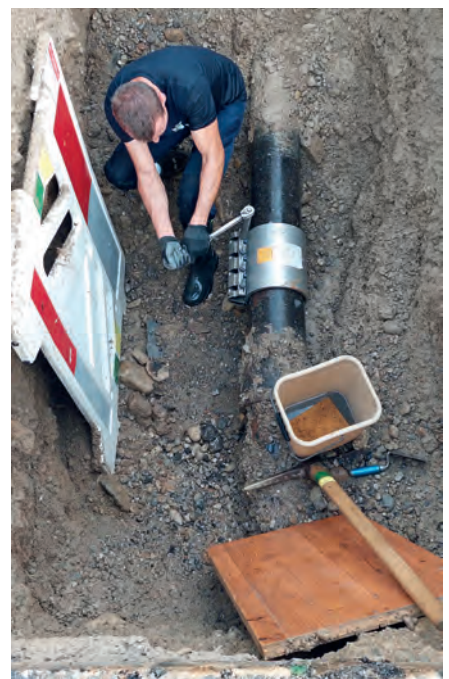
Freilegung und Reparatur von Rostloch an der Hauptleitung mit 200 mm Durchmesser in der Hauptstrasse beim Kafihus 12.
