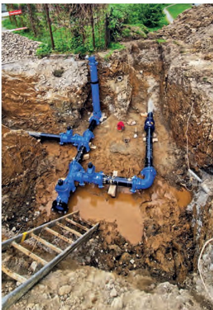
Bild links: Beim Ersatz der Hauptwasserleitungen im Bereich Schafbüchel ergab sich eine komplexe Schieberkombination. Damit der Hydrant immer mit Wasser versorgt ist (auf dem Bild ist nur der Teil im Boden ersichtlich).
