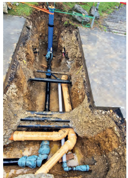
Bild links: Beim Ersatz der Hauptwasserleitungen im Bereich Schafbüchel ergab sich eine komplexe Schieberkombination. Damit der Hydrant immer mit Wasser versorgt ist (auf dem Bild ist nur der Teil im Boden ersichtlich).
